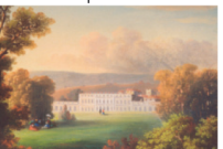
3 ème phase de construction / 3th phase of construction
